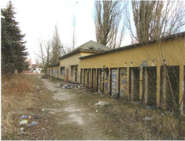
Widok budynku zaplecza basenu od strony ogrodowej (niecki basenu)
